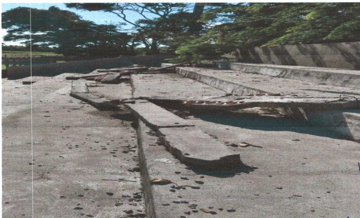
Parte da Alvenaria Derrubada, danificando o contrapiso
