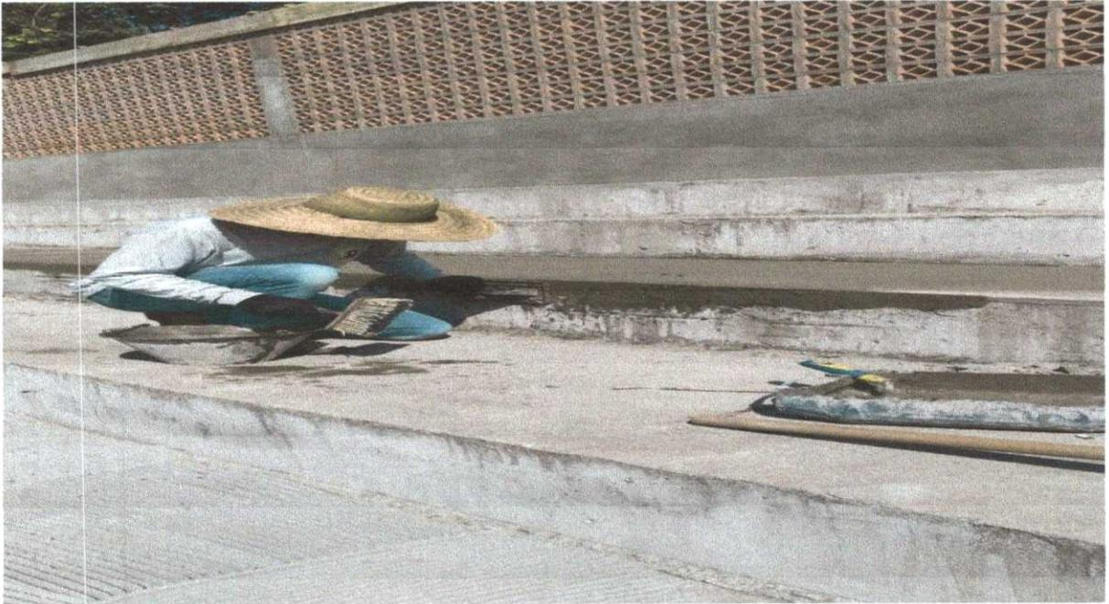
Alvenaria pronta faltando desformar a viga e execução contrapiso
