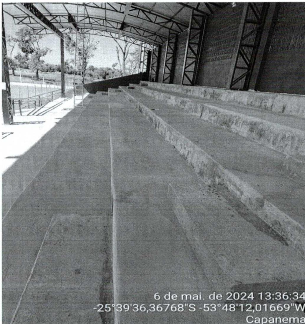
Figura 01-piso novo para correção das áreas "ocas"
