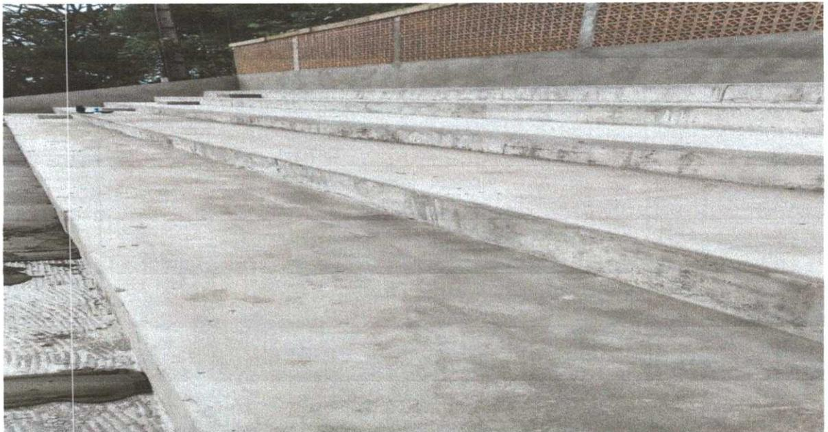
Alvenaria pronta faltando desformar a viga
