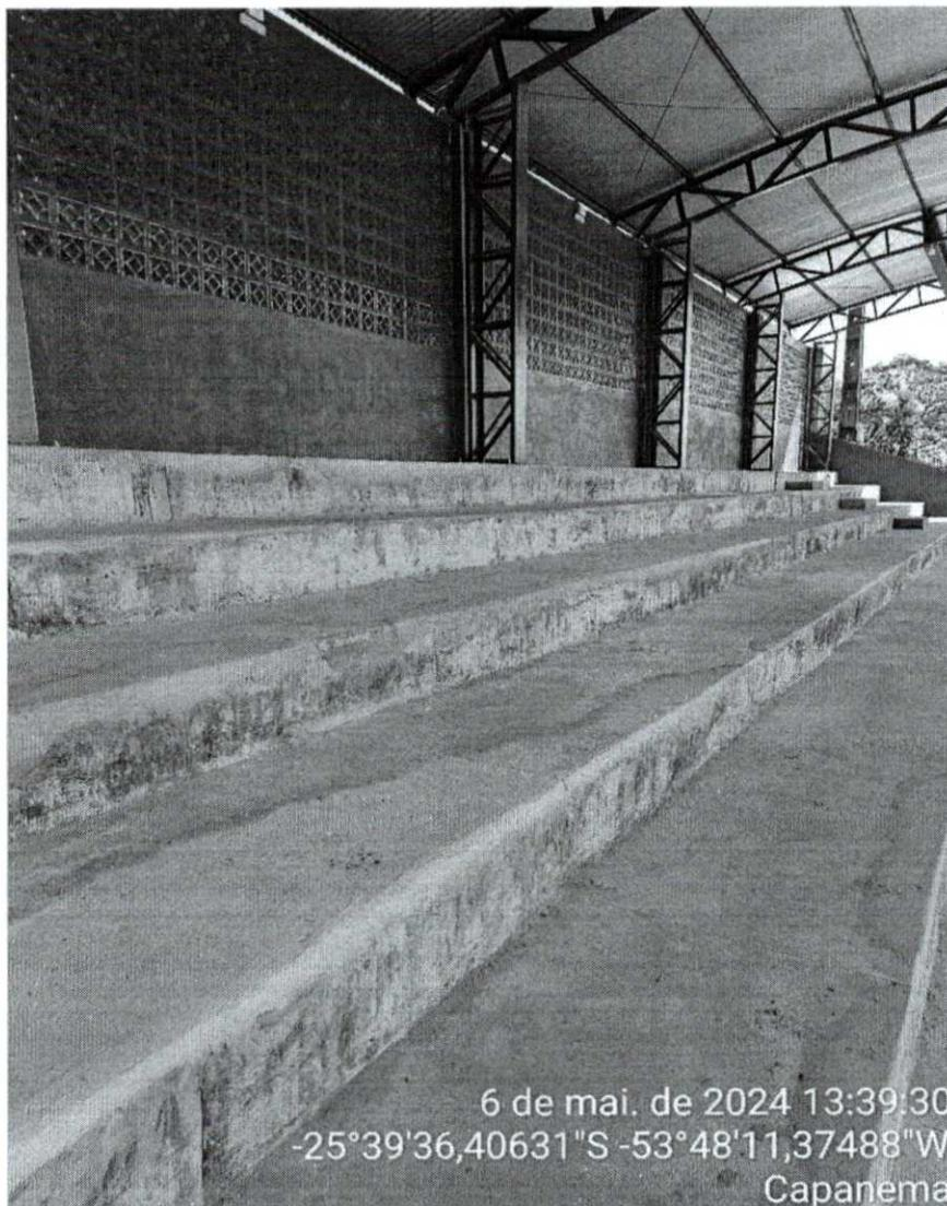
Figura 06-piso novo para correção das áreas "ocas", juntas de dilatação.
