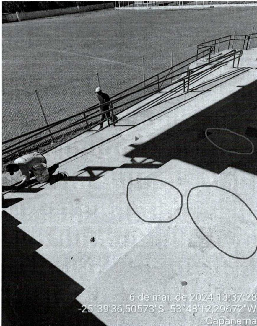
Figura 03- juntas de dilatação preenchidas com selante.
